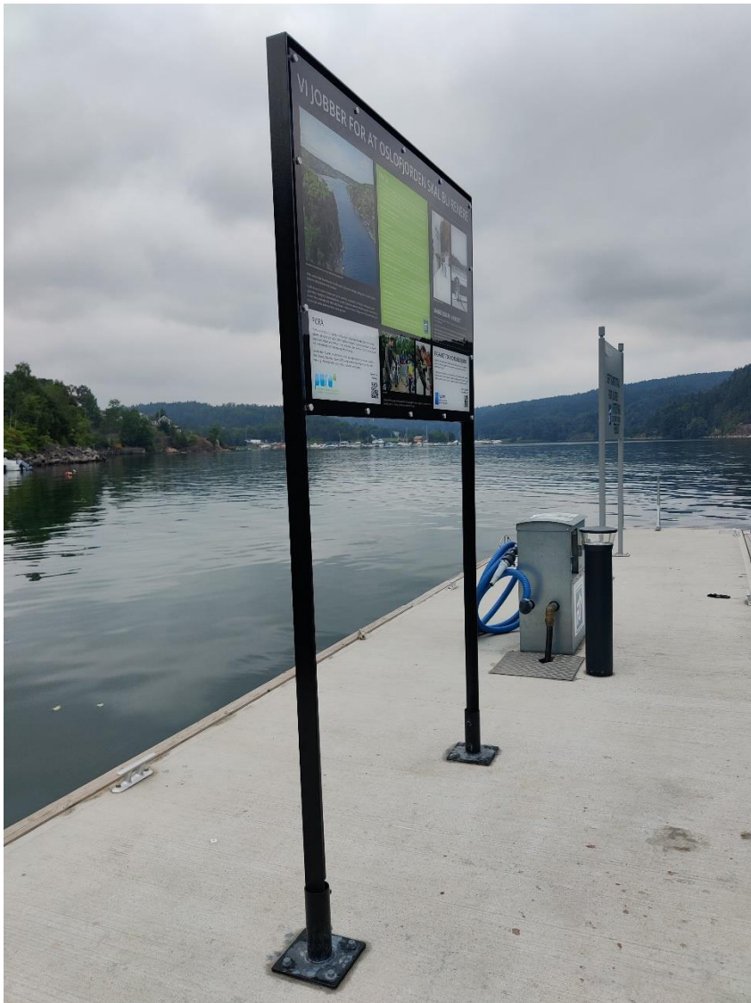
Bildet: Pumpe og to informasjonsskilt på en flytebrygge utgjør PURAs mottak for båtseptik ved Nesset i Bunnefjorden. Foto: PURA.
