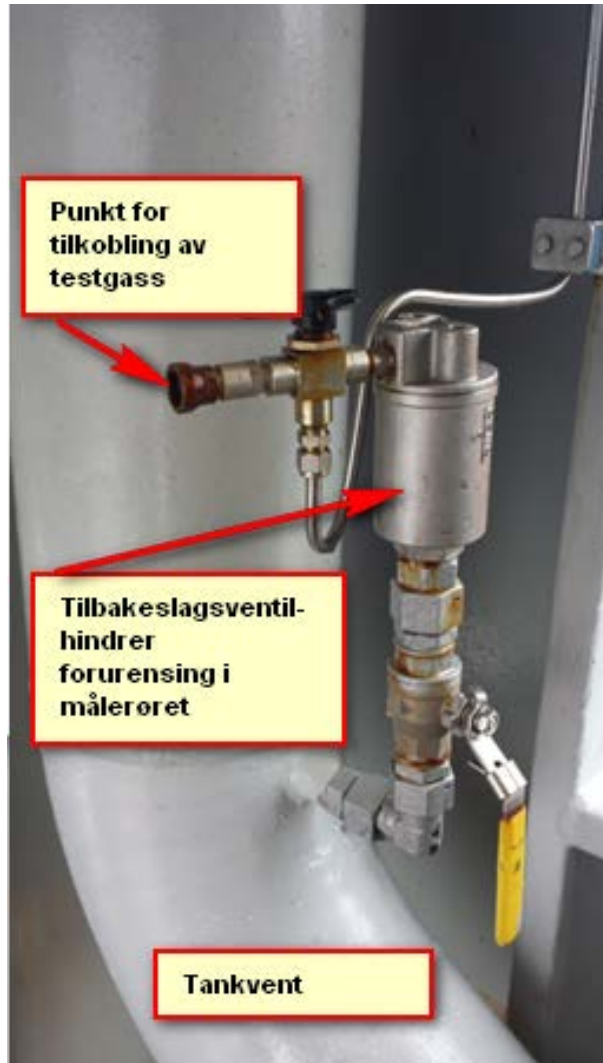
Detalj som viser tilkobling til ventrøret
